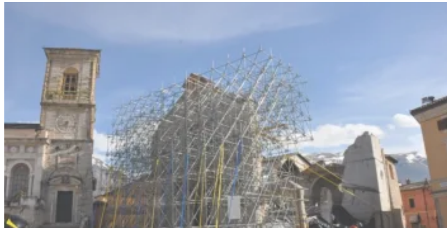
Ripresa dei lavori per la Basilica di San Benedetto di Norcia 9 Maggio 2020
