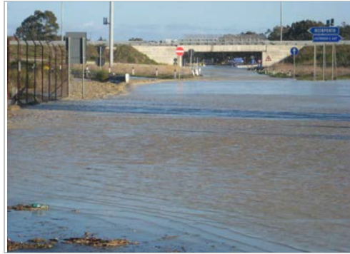
Figura 7.39 – Esondazione del Fiume Basento (marzo 2011) e allagamento della S.S. 407 Basentana all'innesto con la S.S. 106 Jonica, in località Metaponto di Bernalda (Fonte: Autorità di bacino della Basilicata, 2015)
