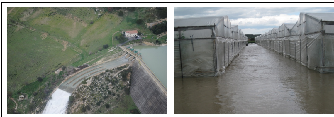
Figura 7.48 – Evento 9-11 marzo 2012, scarico diga di Ragoletto sul Fiume Acate-Dirillo e allagamento dei terreni agricoli a coltivazione intensiva (serre) - Fonte: Genio Civile di Ragusa.
