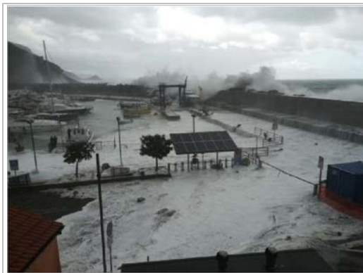
Figura 7.36 – Mareggiata al porto di Maratea (PZ) marzo 2018 (Fonte: https://www.lagazzettadelmezzogiorno.it/ )
